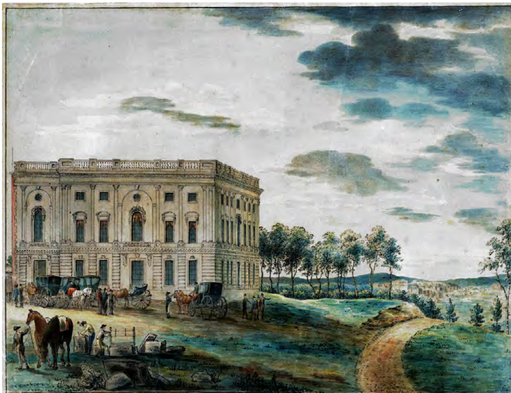
Första gången kongressen sammanträdde i Washington D.C. var det i en mer anspråkslös byggnad än dagens Kapitolium.
